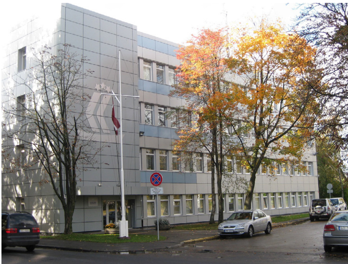
1.9. attēls. Latvijas Jūras administrācijas galvenā ēka Trijādības ielā 5, Rīgā
