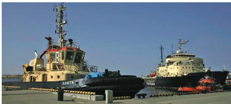
Rīgas ostas pārvalde pie KSV ēkas uzbūvēja piestātņi velkoņiem, loču kuģiem un ledlauzim „Varma”.
