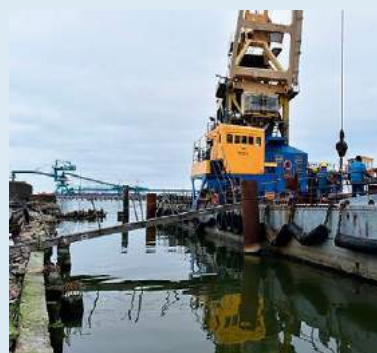
Krasta stiprinājuma izbūvē iesaistīts liels skaits BMGS tehnikas. Pie peldošā celtna “Astrahaņa” pievieno greiferu, ar kuru tīra Ventas gultni.
