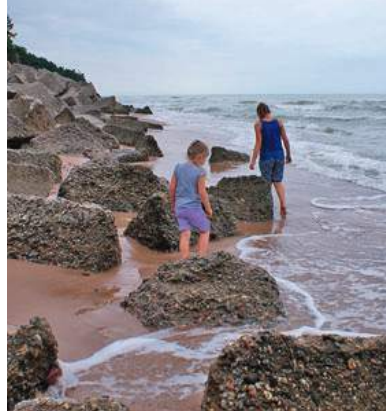
Krasts pie Užavas bākas ir nostiprināts ar betona blukļiem, lai aizsargātu bāku pret jūras uzbrukumu.
