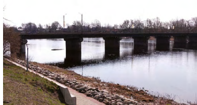
Piešķirts finansējums Salacgrīvas tilta pārbūvei.
